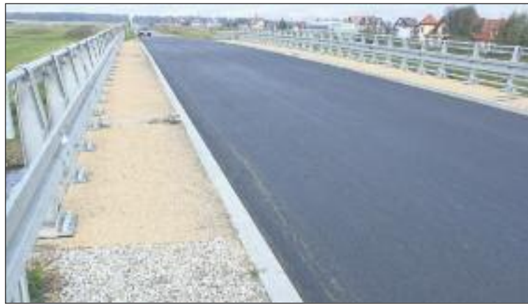
Modernizacja drogi Dębno – Niedzica jest na ukończeniu.
